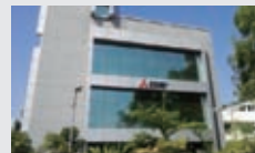
Pune/Gurgaon/Bangalore, India インドFAセンター
